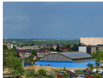
Nowa hala w Skarżysku Kamiennej
